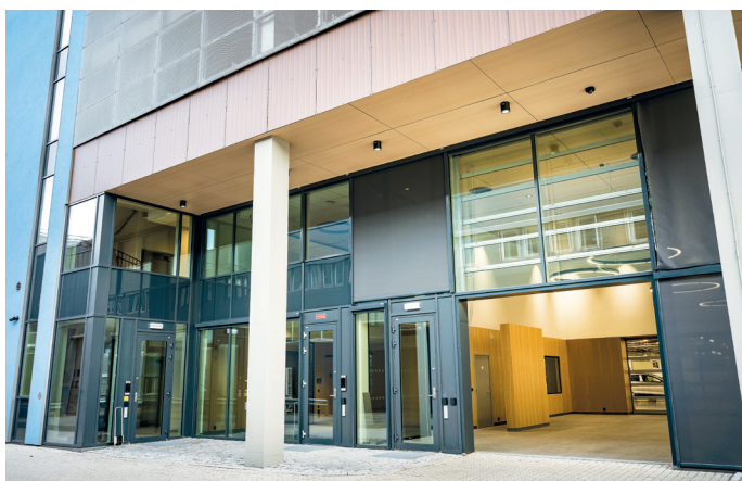
Det er entreprenøren Alento, med hovedsete på Lierstranda, som har stått bak utbyggingen av det nye logistikk-anlegget.
